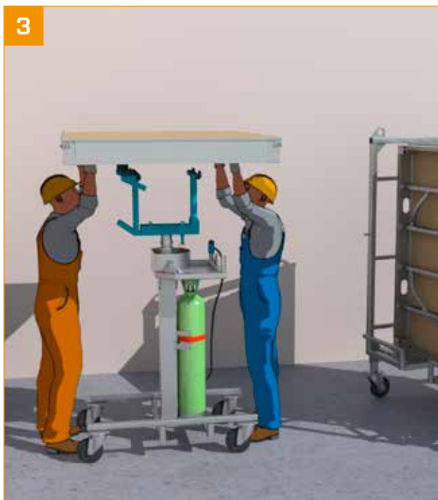
3 - Das erste Paneel wird flach und mittig auf den Kopf des Geräts gelegt.
