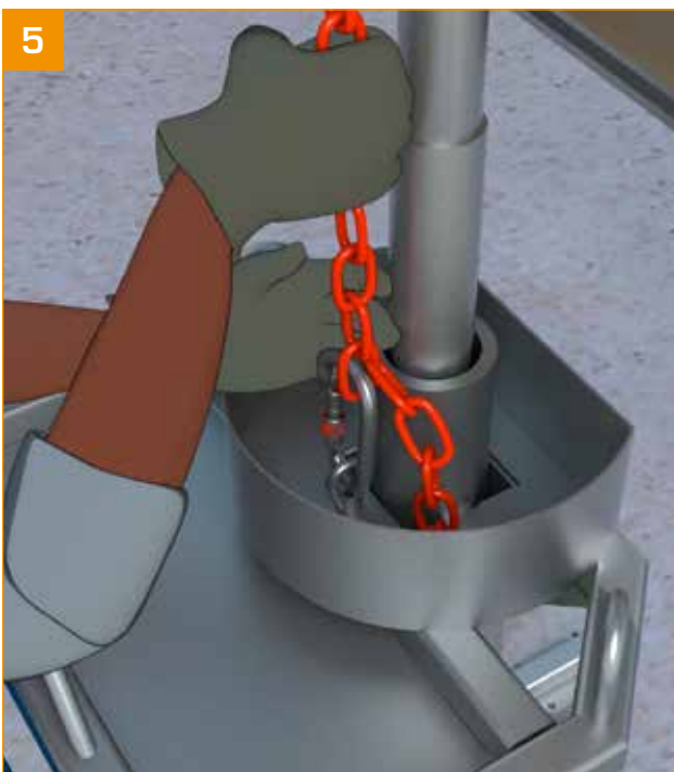
5 - Fixieren Sie die Kette mit dem Karabinerhaken, um die gewünschte Höhe bei der Installation der nächsten Paneele bereits vorzugeben.
