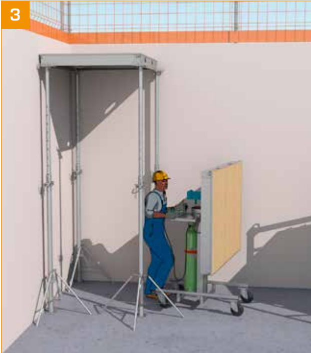
3 - Positionieren Sie den MaxUp an der gewünschten Stelle, wozu sich der Monteur unter das bereits installierte Paneel stellt.
